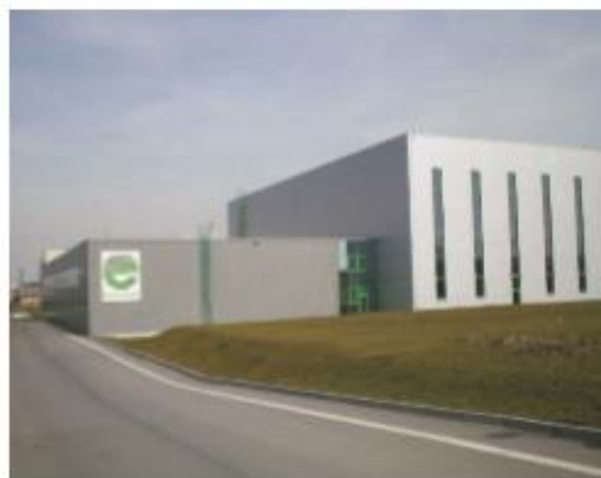
EUROPAPIER Praha 10 realizace 1999 výměra 5500 m 2
